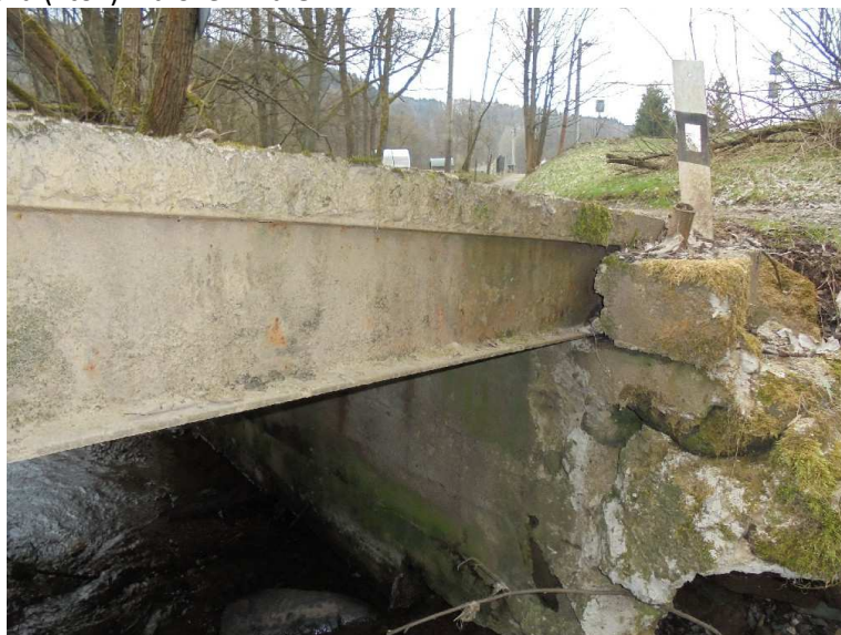
14) NK – boční detail zleva (vtok) – uložení na OP1
