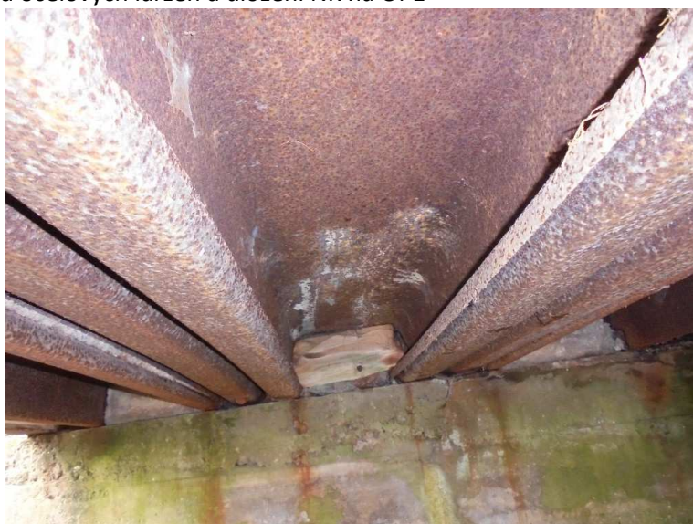
15) NK – typický podhled ocelových larzen a uložení NK na OP1
